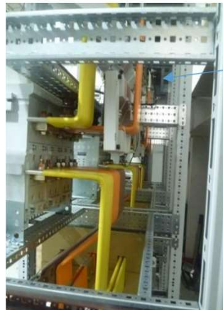
Foto No. 1 y 2. Gabinetes donde se ubican los tres interruptores de potencia del sincronismo
