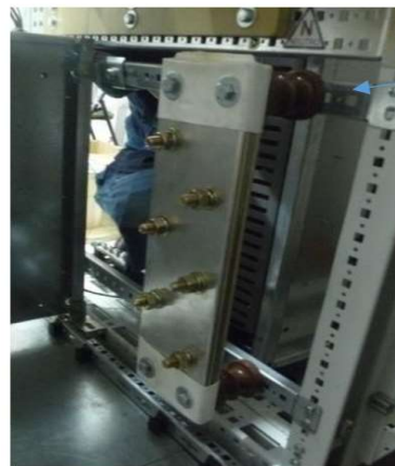
Foto 3 y 4. Ubicación en cada gabinete en la parte posterior tanto del neutro y la tierra.
