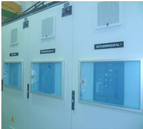
Foto No. 1 y 2. Gabinetes donde se ubican los tres interruptores de potencia del sincronismo
