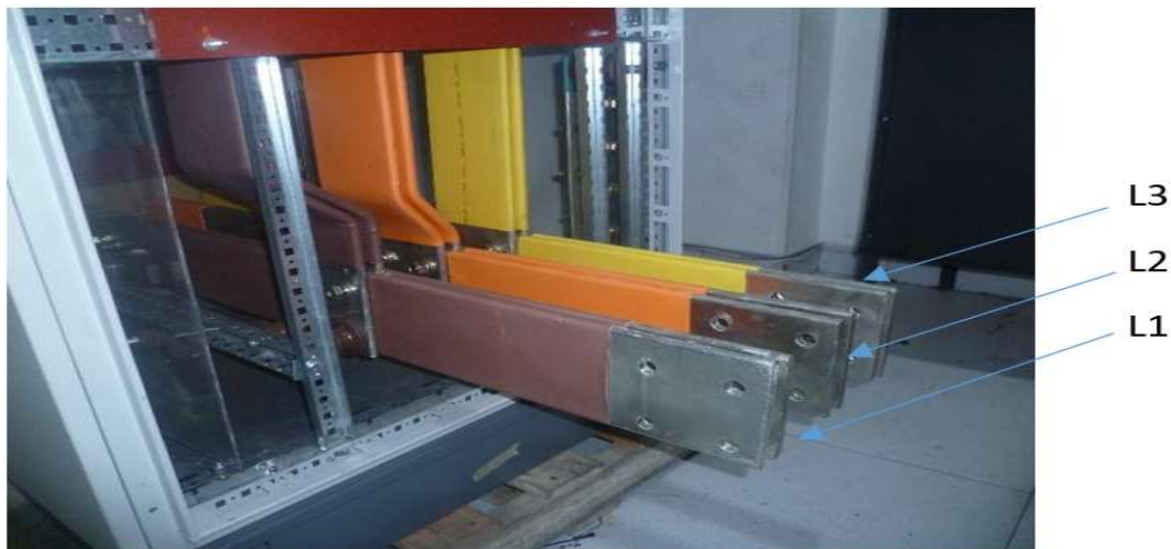
Foto No.5. Barras horizontales de acople en Tb. Sincronismo
